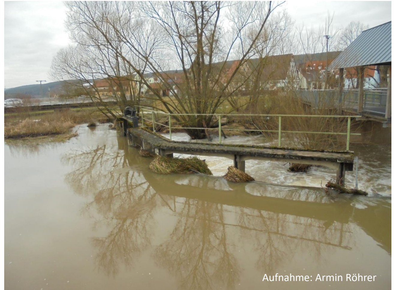
Wehr und Beginn eines Mühlkanals
