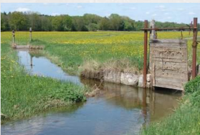
Abb. 5: Wässerwiesen im Rednitztal. Grabenstausystem, hölzerne Schützenplatten. Foto: Umweltamt, Stadt Nürnberg
